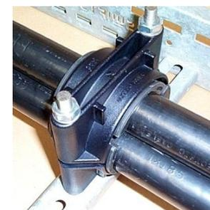
4) Fermez le collier et serrez. **Important:** ne pas trop serrer le collier. La Gaine de Câble Triplex doit être en contact avec les câbles mais elle n'a pas besoin d'être si serré que les câbles sont déformés.
