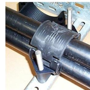
3) Faites glisser la Gaine de Câble Triplex le long des câbles jusqu'à ce qu'elle soit en position dans le collier.
