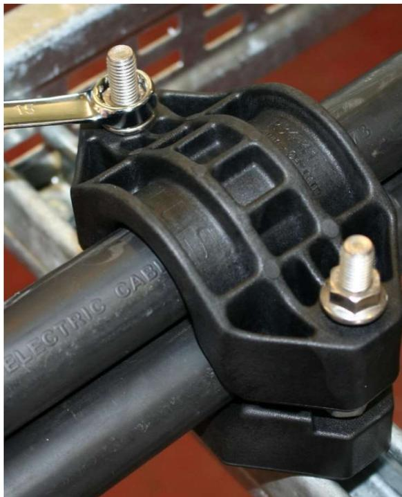
**Par** Las tuercas necesitan ser apertadas a un par máximo de 10Nm. Esta valor es basada sobre la fuerza de la abrazadera más que sobre el cable instalado dentro. ver el artículo 4 de las directivas de Ellis sobre las abrazaderas de cables. .
