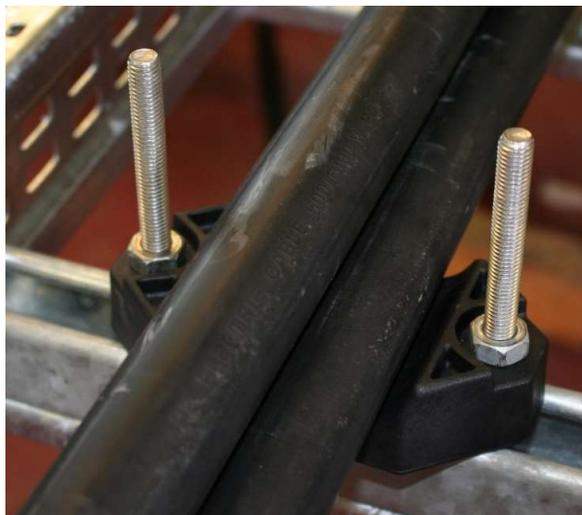
4) Instale la parte superior de la abrazadera sobre la base. Apertando, las tuercas M10 aseguran que las tuercas están apertadas equitativamente para asegurar que la parte superior sea instalada recta.
