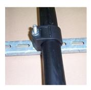
4) Important: Ne pas trop serrerla bride. Le revêtement enpolymère doit être en contactavec le câble, mais il n'a pasbesoin d'être si serré que lecâble est bombé de chaquecôté de la doublure.
